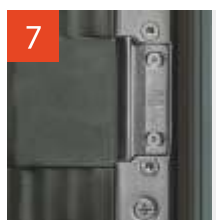
7 ZACZEP Z REGULACJĄ DOCISU ZAMKA
